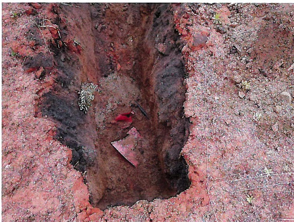
Foto č. 09: Původně kopaná sonda KS-4 – v 1,0 zastižen kabel
